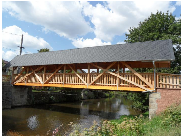
Obr. 9: Krytou lávku tvoří dvojice příhradových přímopásových nosníků s dolní mostovkou
