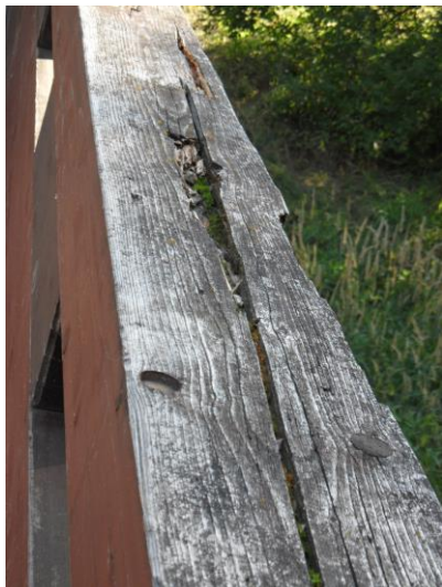
Obr. 24 a 25: Výsušné trhliny zábradlí z rostlého i lepeného dřeva se zanášá a do dřeva proniká více vlhkosti
