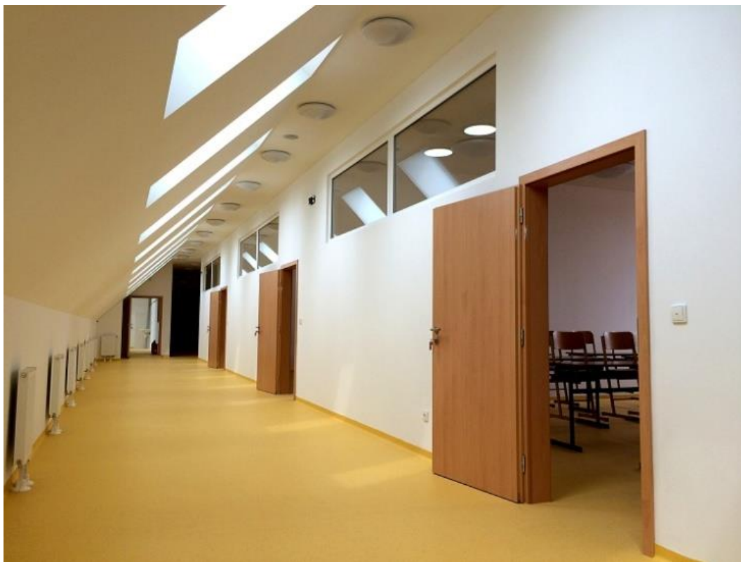
Obr. 8: Foto ze stavby – Varianta 3B - 411-7 Kmenová učebna – fotografie nově vzniklé půdní vestavby, průhled do učebny s viditelnými světlovedy (zdroj: https://www.senkyrik.cz/fotogalerie#1308 )
