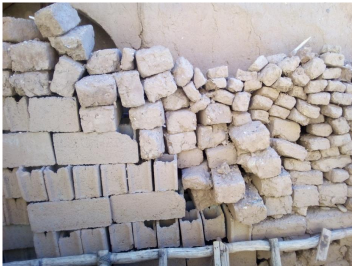
Obr. 2: Nepálené cihly různého formátu. Vlevo jde vidět imitace. Bednící tvarovka z betonu povrchově potřena řídkou hliněnou směsí („špryc“).
