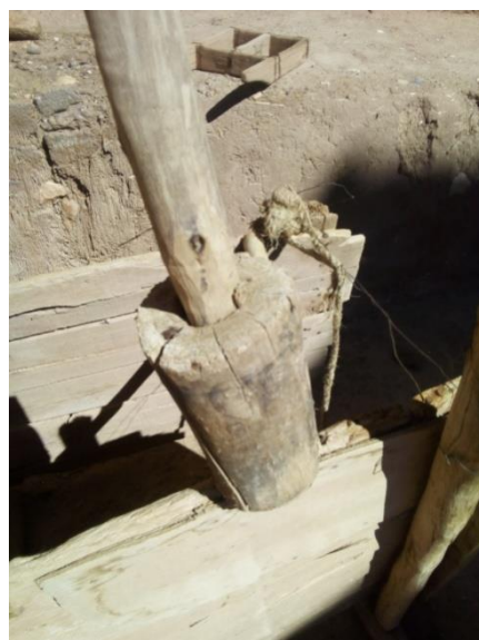
Obr. 4 a 5: Bednění a dusadlo pro výrobu dusaných hliněných stěn.
