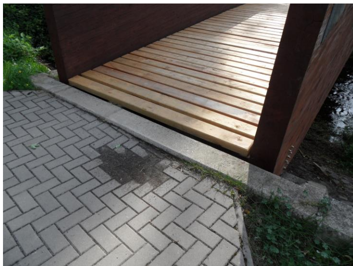
Obr. 22: Vyměněná mostovka prodlouží životnost lávky
