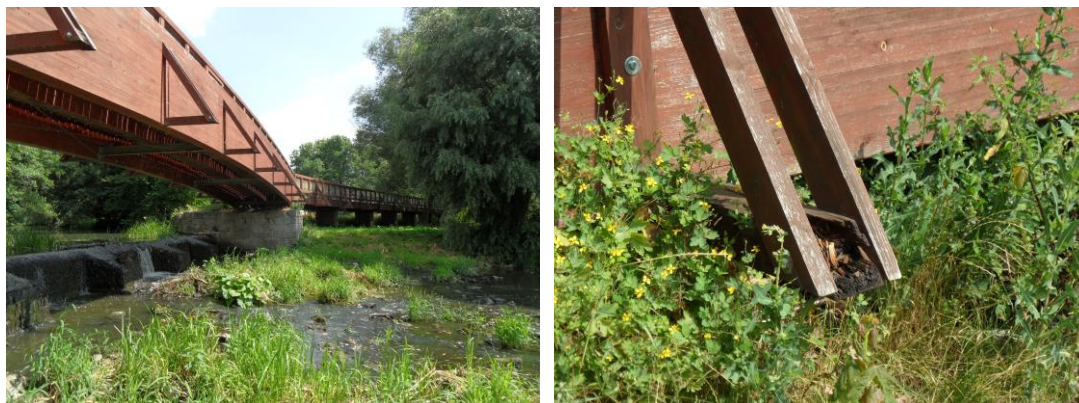
Obr. 19 a 20: Architektonicky zajímavý prvek – avšak biologické poškození vodorovného prvku z rostlého dřeva. Koncová vlákna jsou vystavena povětrnostním vlivům.
