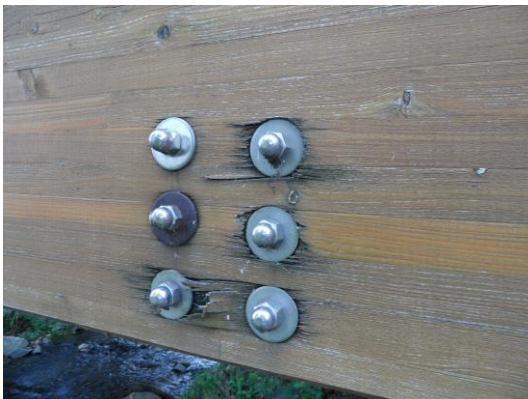
Obr. 31 a 32: Nekrýtý svorníkový spoj a nadměrné dotažení svorníků
