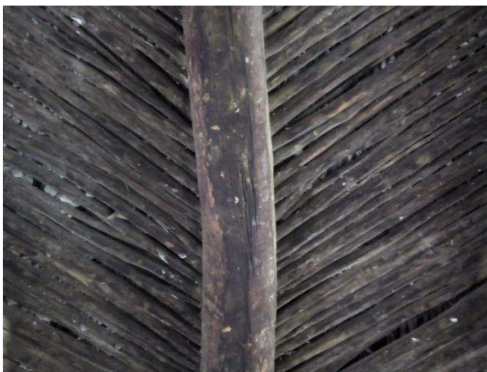
Obr. 10: Dřevěná stropní konstrukce
