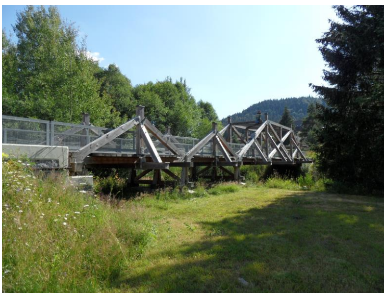
Obr. 14: Věšadlový most – kombinace jednoduchých a dvojnásobných věšadel
