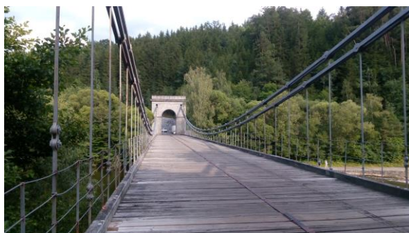
Obr. 15: Visutý řetězový most umožňuje i přejezd vozidel
