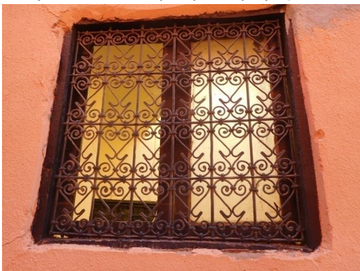
Obr. 18: Kované mříže oken.
