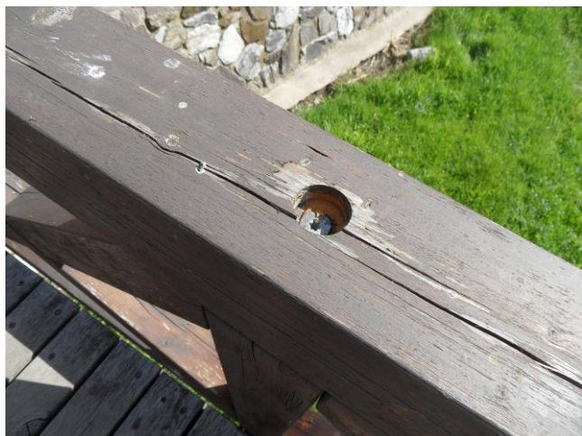
Obr. 28 a 29: Chybějící zátka chránící spojovací prvek a degradace zábradlí
