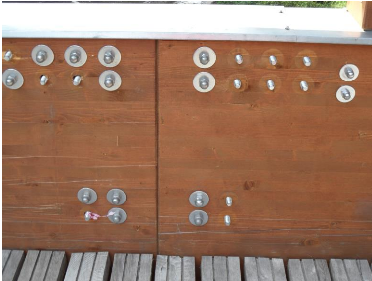
Obr. 34: Chybějící podložka a matice
