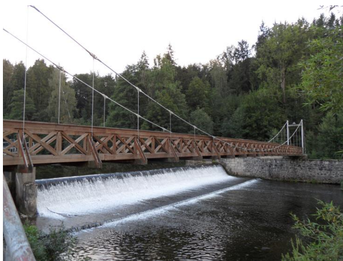
Obr. 16: Visutý most s výztužným nosníkem
