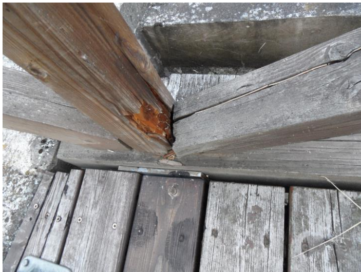
Obr. 23: Nevhodný konstrukční detail způsobuje degradaci dřeva - voda zatéká do spoje.
