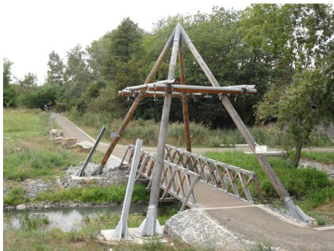
Obr. 2: Zvedací lávka na cyklostezce v Mladé Boleslavi byla navržena kvůli hrozbě povodní. Mechanismus umožní v případě hrozící velké vody konstrukci zvednout do výšky.
