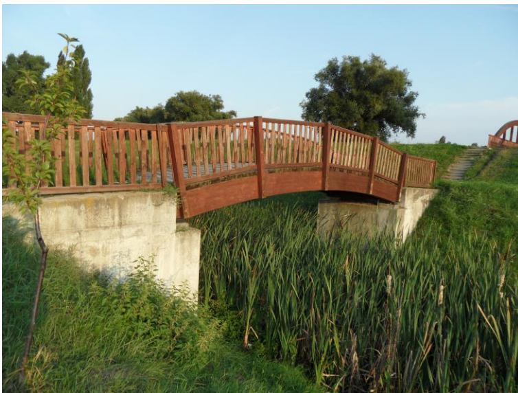
Obr. 8: Dvojice obloukových plnostěnných prostých nosníků z lepeného dřeva s horní mostovkou
