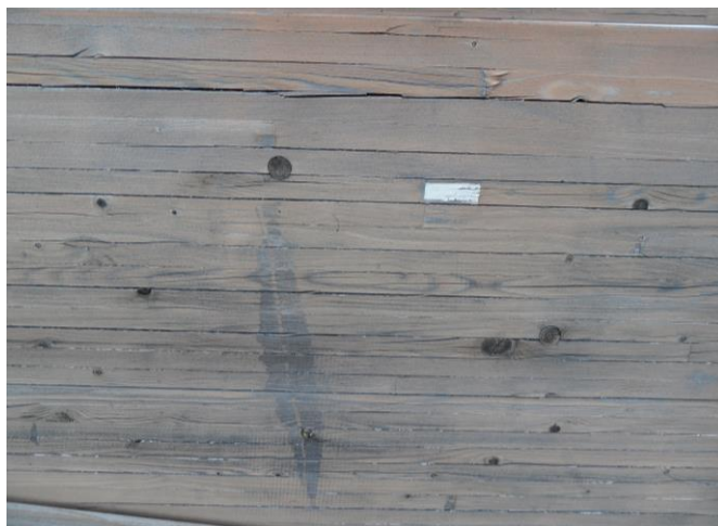
Obr. 30: Delaminace lepeného plnostěnného nosníku na osluněné straně mostu
