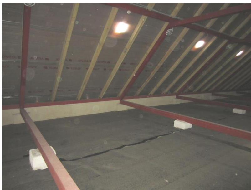
Obr. 2: Pohled na ocelové ráky podélné části krovu z druhé strany
