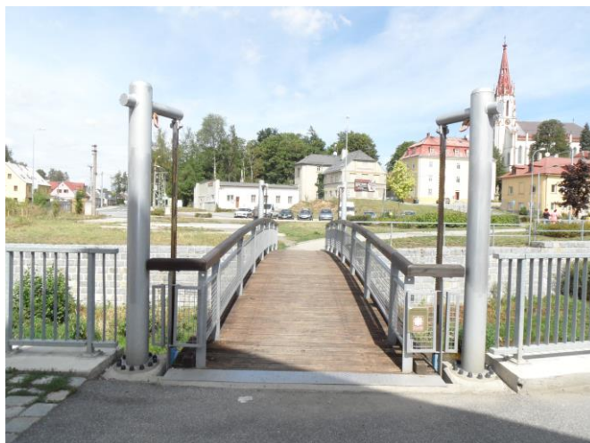
Obr. 1: Lávka se zvedacím mechanismem v Chrastavě - na březích je upevněná vždy na dvou sloupech, po nichž se může posouvat nahoru a dolů, aby při povodních netvořila bariéru.
