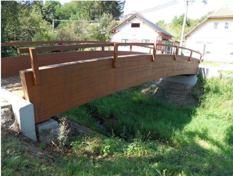
Obr. 7: Dvojice obloukových plnostěnných prostých nosníků z lepeného dřeva s dolní mostovkou
