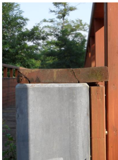
Obr. 26 a 27: Krycí desky zábradlí jsou osazeny nesprávně, tudíž neplní svoji funkci, voda po deštích se zde může hromadit – neodtéká.
