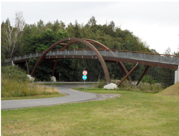
Obr. 12: Obloukový most s mezilehlou mostovkou - plnostěnný oblouk z lepeného dřeva
