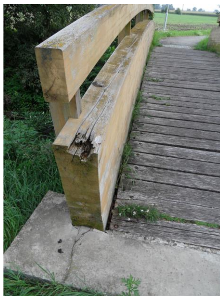
Obr. 22 a 23: Zanedbaná údržba – v mezerách mostovky se zachytily nečistoty i vegetace, degradace nosného prvku.
