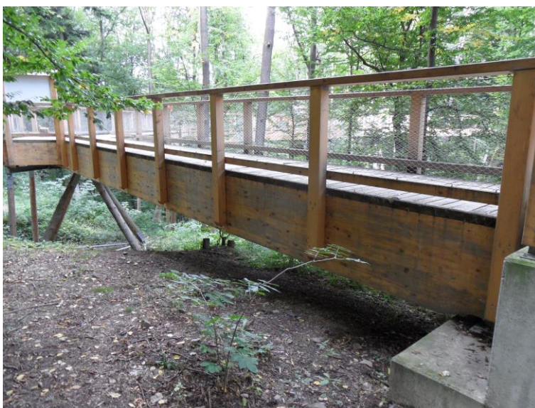
Obr. 6: Dvojice přímých plnostěnných prostých nosníků z lepeného dřeva s horní mostovkou
