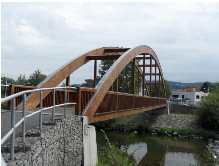
Obr. 11: Obloukový most s dolní mostovkou - plnostěnný oblouk z lepeného dřeva
