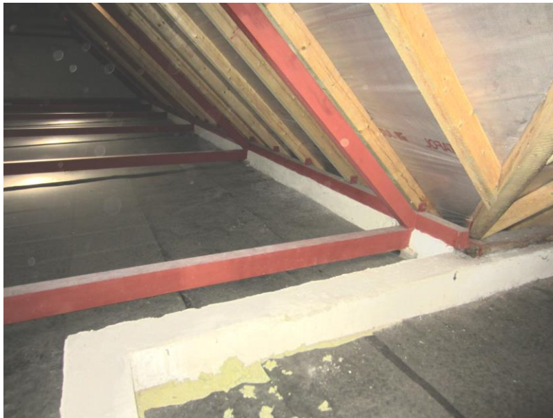
Obr. 1: Pohled na uložení ocelových ráků podélné části krovu
