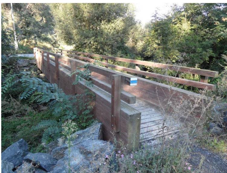
Obr. 33: Okolí mostu neumožňuje vysušení dřeva proudem vzduchu
