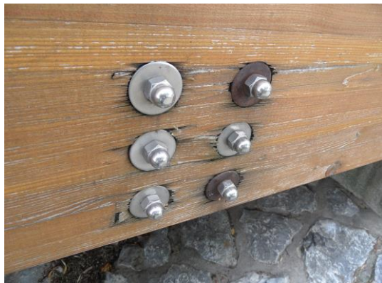
Obr. 31 a 32: Nekrýtý svorníkový spoj a nadměrné dotažení svorníků
