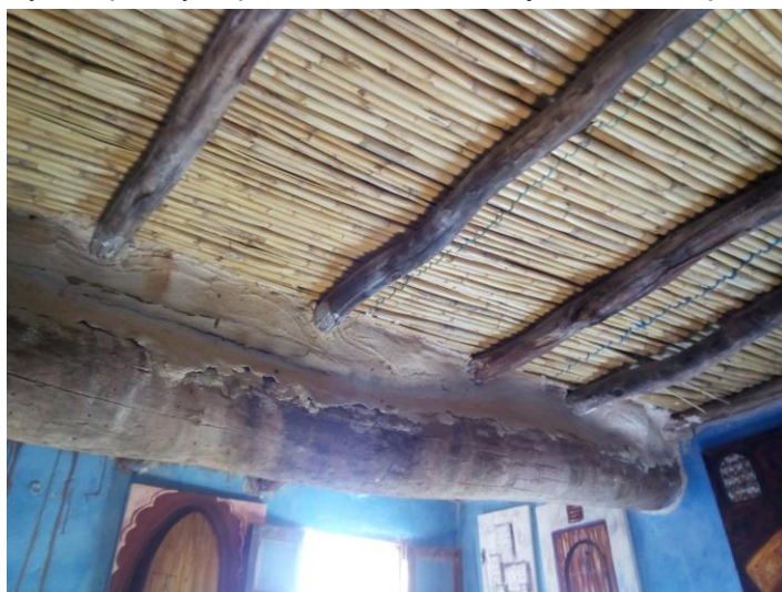
Obr. 11: Styk průvlaku a stropních nosníků se záklopem z plošně vyskládaných klacků.
