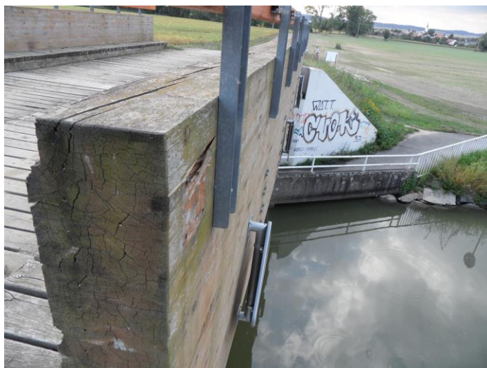
Obr. 23: Zanedbaná údržba – výsušné trhliny lepeného nosníku
